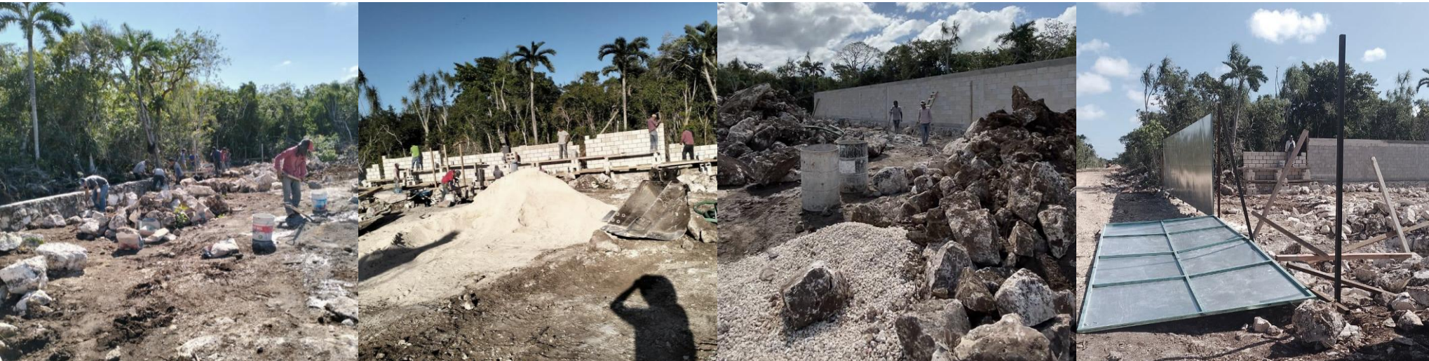
Desarrollo Natura – Subcontrato de albañilerías – Enero 2024
