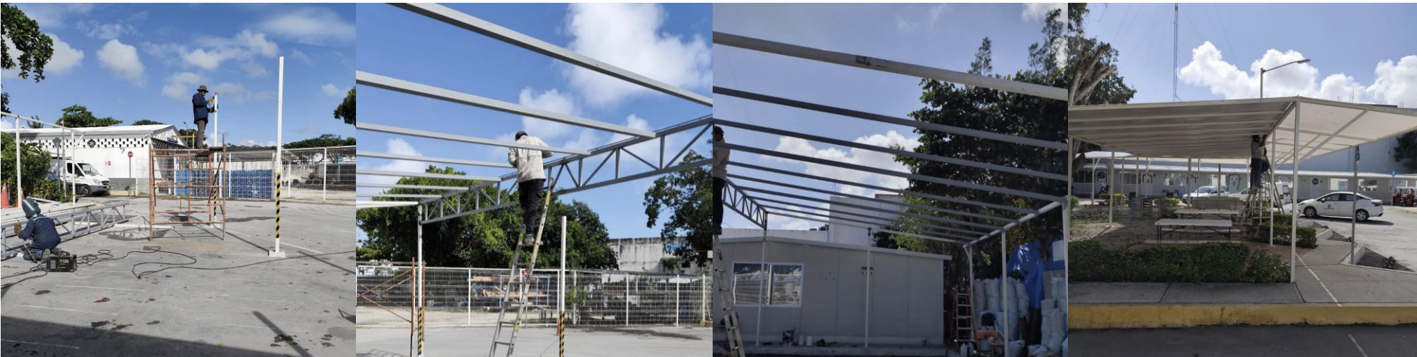
Aguakan – Diseño y construcción de cubiertas ligeras – Junio 2024
