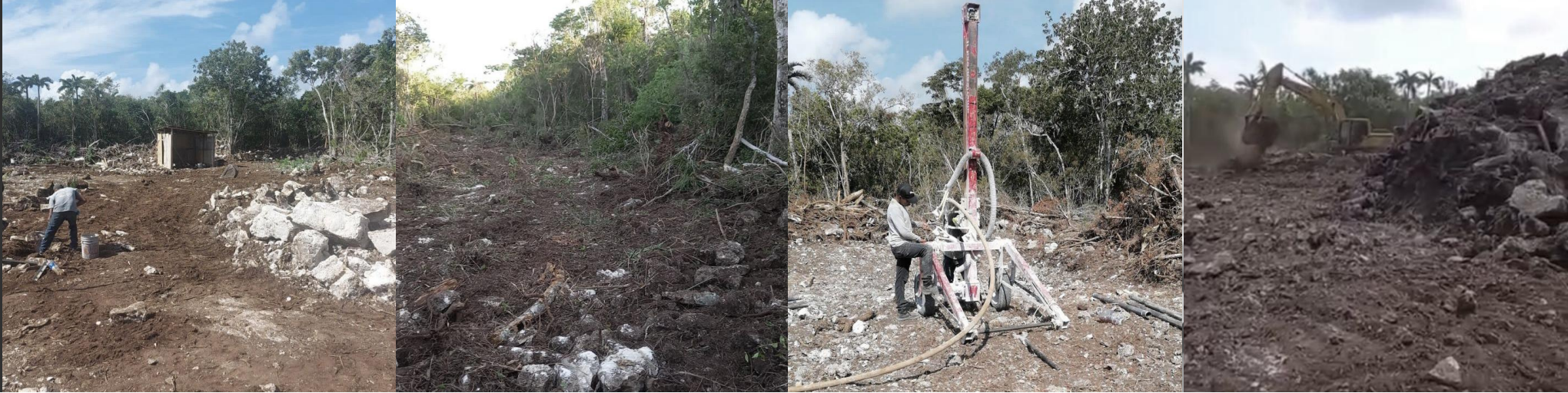
Desarrollo Natura – Trabajos preliminares, topografía y mecánica de suelos – Noviembre 2022
